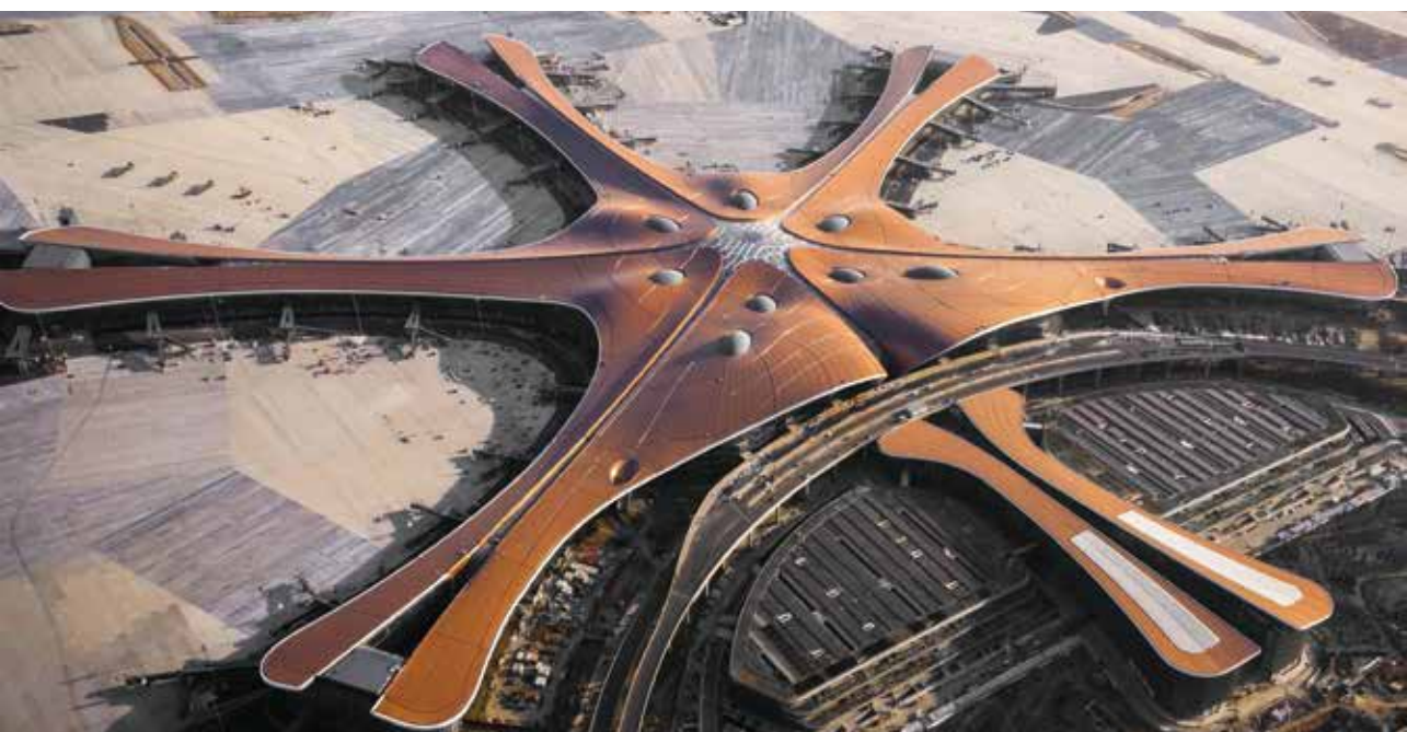
国检集团连续多年服务国家重点工程质量保障及环境控制。图为服务保障的北京大兴国际机场项目
