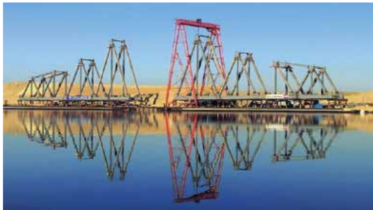
埃及跨苏伊士运河双平旋铁路大桥项目
