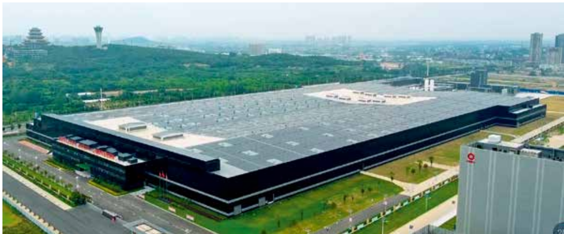
世界单体规模最大的薄膜光伏建筑一体化应用项目
