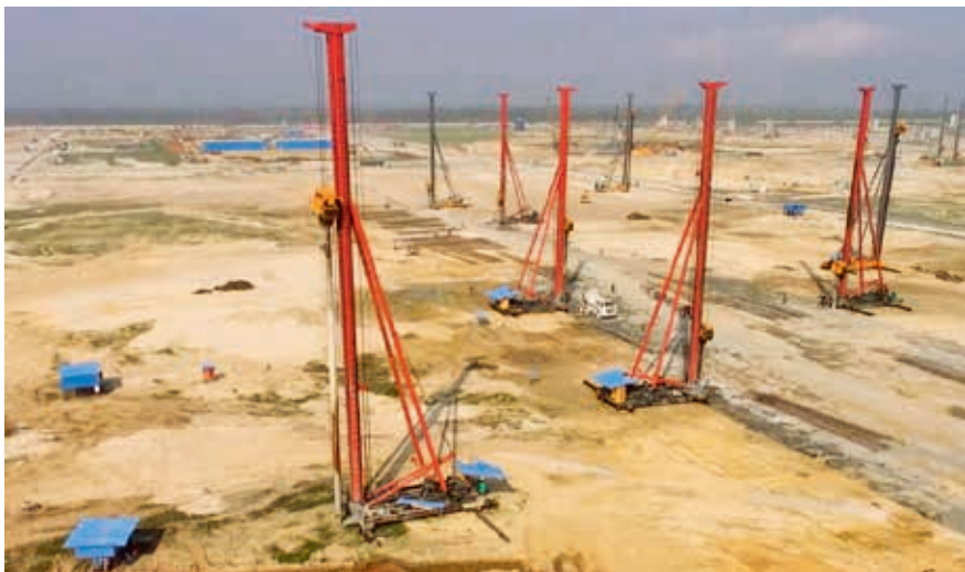
尼日利亚丹格特炼化厂水池基桩工程
