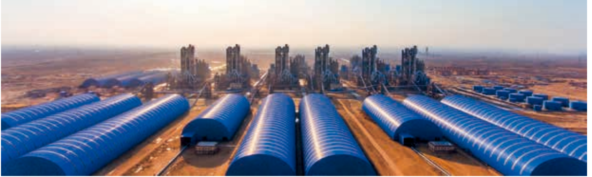
埃及GOE Beni Suef 6X6000TPD熟料水泥生产线
